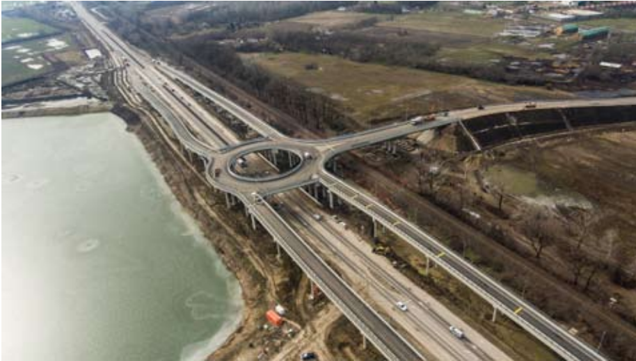
A 47-es út hódmezővásárhelyi elkerülő szakaszának végcsomópontjánál épült kopáncsi körhíd (MTI Fotó: Miniszterelnökség)
