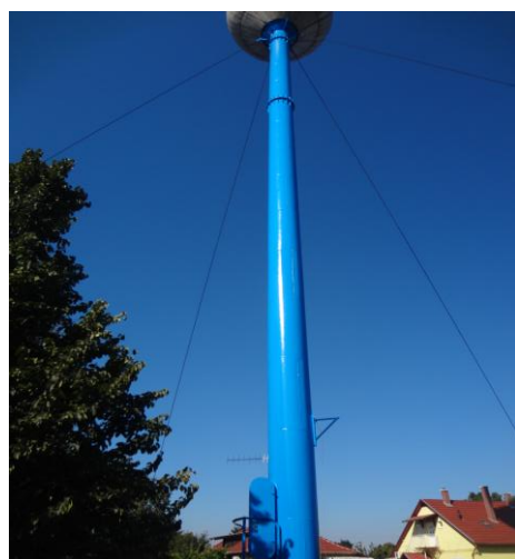
A HG 100/30,5 típusú acél szerkezetű magas víztároló tartó csőszárának külső része a rekonstrukciót követően
