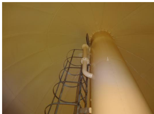
A HG 100/30,5 típusú acél szerkezetű magas víztároló víztere a rekonstrukciót követően
